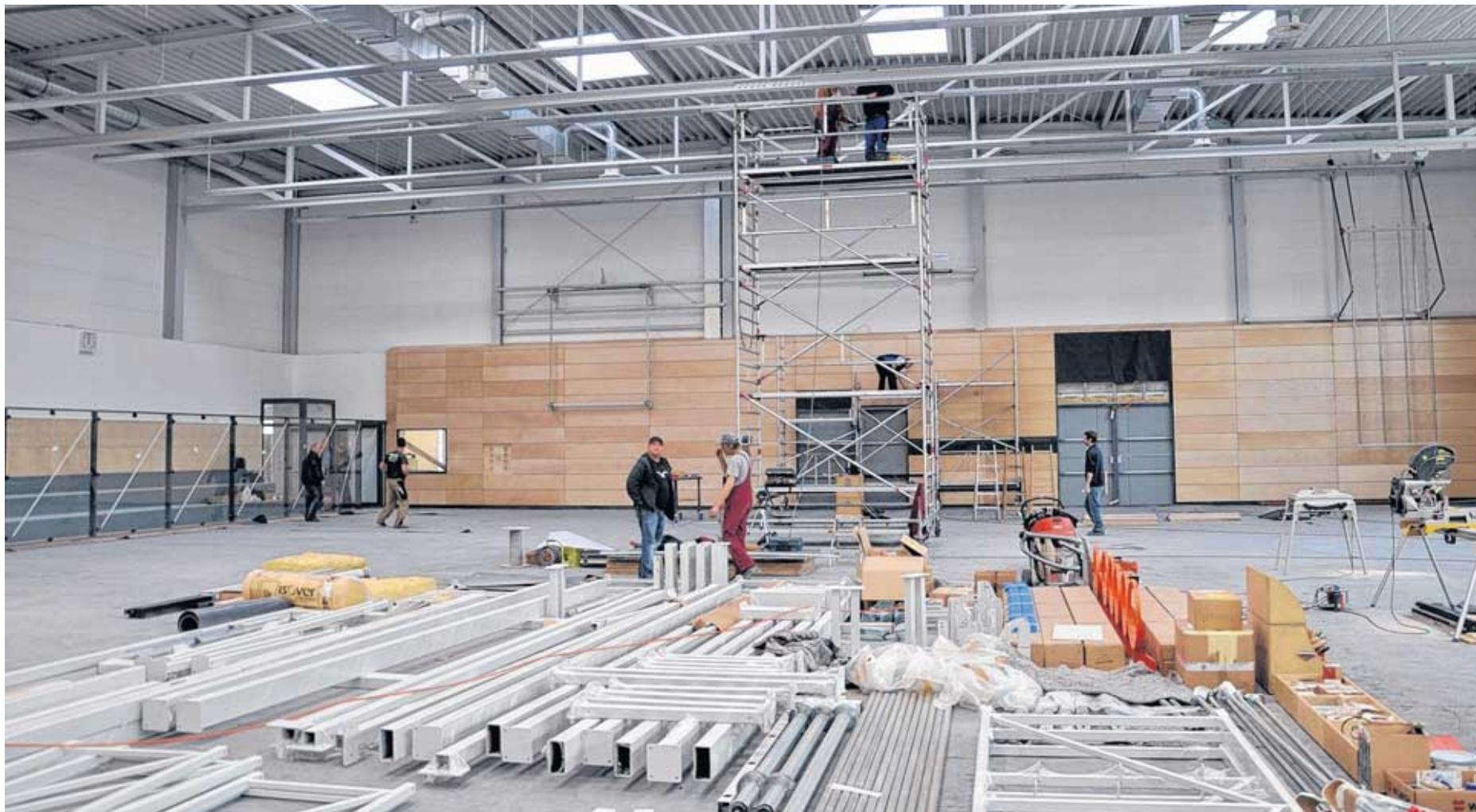
Noch ist der Hallenboden mit Abdeckmaterial versehen, auf dem verschiedene Ausrüstungsgegenstände für das Innenleben der Halle liegen. Mit Hilfe des Gerüsts in der Mitte können Arbeiter unter der Decke die Beleuchtungsanlage montieren. Ganz hinten wird an der Vervollständigung der Prallwand gearbeitet.
